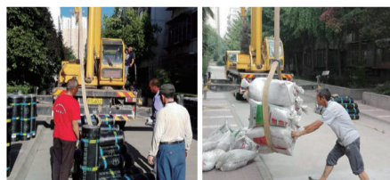
后勤管理处全力以赴抓保障 不辞辛劳全力做好专项维修改造工作
