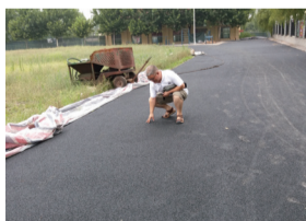
工作人员在烈日下查看沣峪校区建设情况
